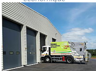
Maison des entreprises qui héberge le pôle développement économique
