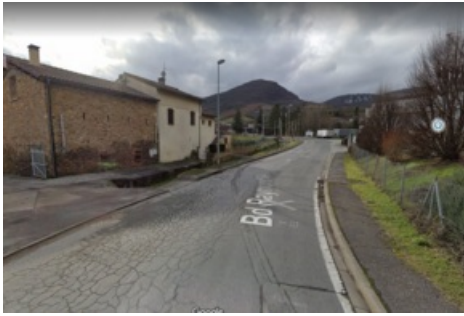
Illustration Google maps du boulevard concerné par les travaux
