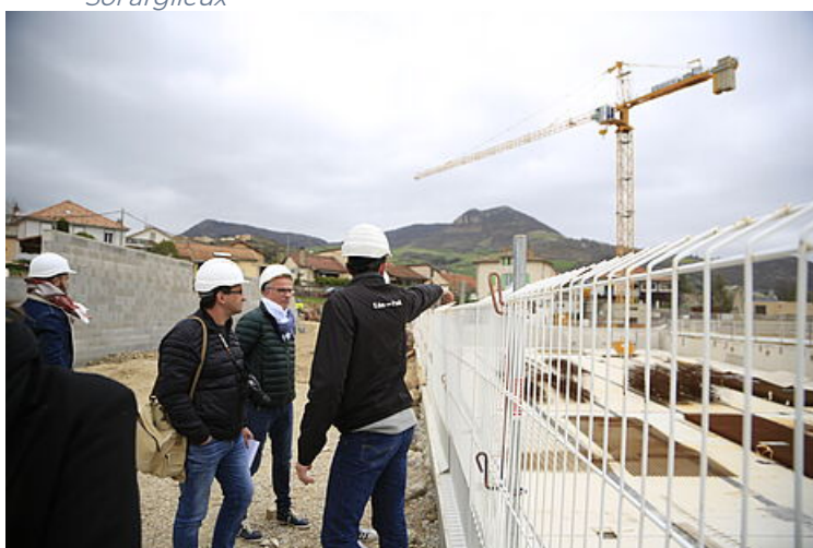
Explications autour du bassin extérieur
